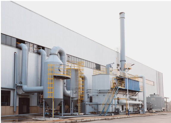
亚士防水科技（滁州）有限公司 RTO 进行废气处理
