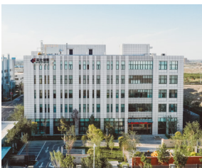
乌鲁木齐综合智能制造基地科研大楼
