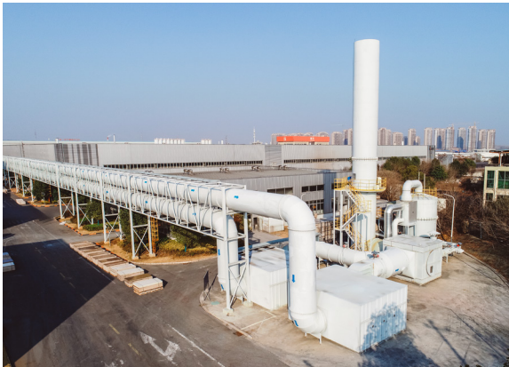
亚士创能科技（滁州）有限公司投资逾千万建设 RTO 系统进行废气处理
